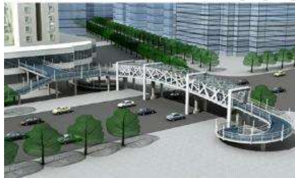
شکل (۱) پل عابر پیاده شنژن ، منطقه شنژن نانشن، چین
