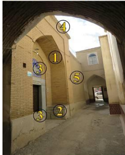
۱- قوس پنج او هفت ۲- سکو پیرنشین ۳- کتیبه کاشی ۴- رخ بام ۵- مصالح استفاده شده: خشت و آجر
