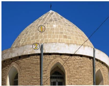
۱- گنبد یک پوسته ۲- مصالح استفاده شده: خشت و آجر
