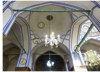
۱- طاق کلبو ۲- کاربندی ۳- چوب تقویتی (به منظور جلوگیری از رانش) ۴- مصالح استفاده شده: خشت و آجر
