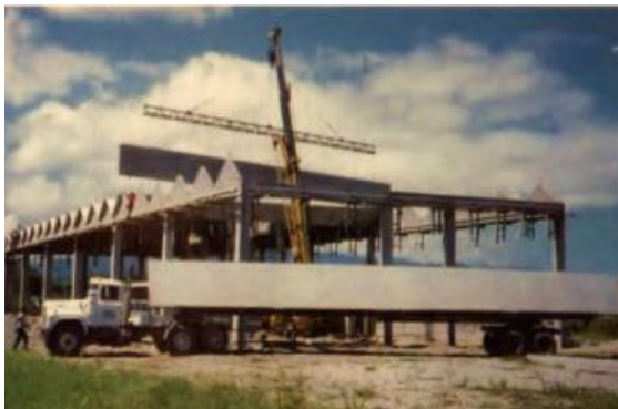
شکل ۶. حمل ورق تاشده پیش ساخته به محل کارگاه
