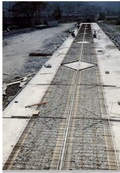
شکل ۳. قالب بندی و مش بندی
