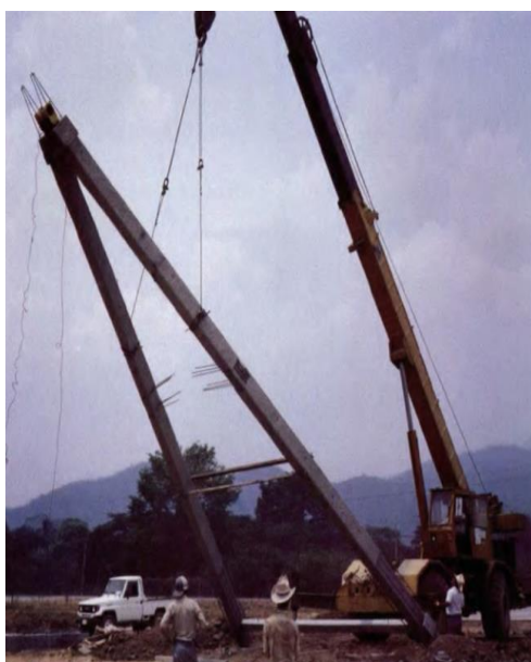
شکل ۱۱. برپاسازی قاب A شکل
