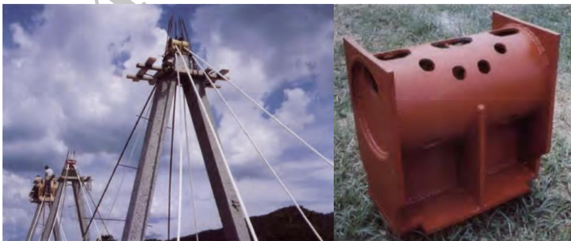
شکل ۱۶. عضو پیش ساخته فلزی برای اتصال بهتر کابل به قاب بتنی
