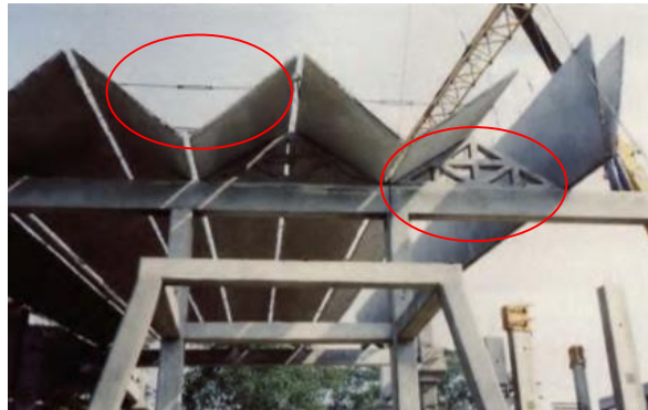
شکل ۷. باز کردن صفحات به اندازه زاویه طراحی شده
