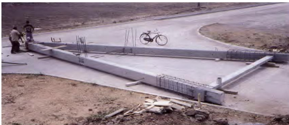
شکل ۹. درجا سازی قاب A شکل
