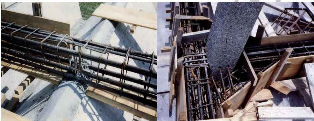
شکل ۱۴ و ۱۵. میلگرد گذاری و قالب بندی تیر های یکپارچه کننده
