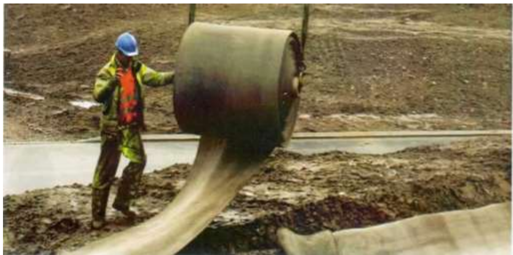
شکل (۱) - بتن پارچه ای در حال پهن شدن بر روی سطح زمین توسط اپراتور [۱].
