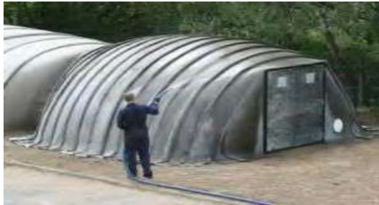
شکل (۱۱) - مراحل ساخت پناهگاه با مصالح بتن پارچه ای [۳].
